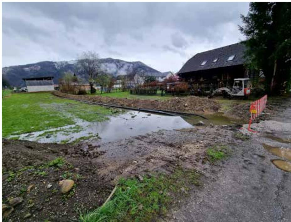
**D**as Gebäude der Freiwilligen Feuerwehr Altenmarkt wurde an die Heizungsanlage des Bauhofes angeschlossen. Die Feuerwehr wurde bis dato mit Strom beheizt. Durch die wärmetechnische Sanierung der Volksschule wurde
